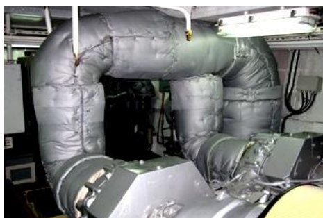
งานตัดเย็บฉนวนหุ้มสำหรับเครื่องแลกเปลี่ยนความร้อน
